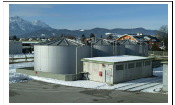
Bild: Großtankanlage (GTA) HLogZ S
